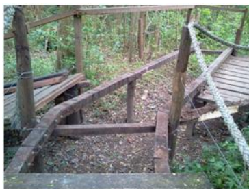
Fotos: reparación del mirador El Abuelo: el antes (izq) y el después (abajo).
